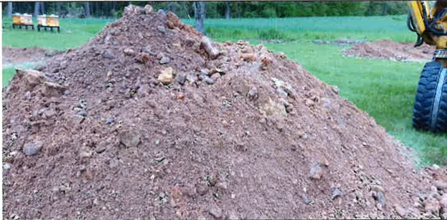
Baggerstich BS 4: Aufnahme ausgehobenes Material am 20.05.2021
