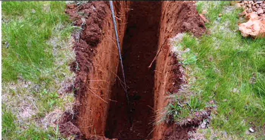
Baggerschurf BS 2: Aufnahme Schurfprofil am 20.05.2021
